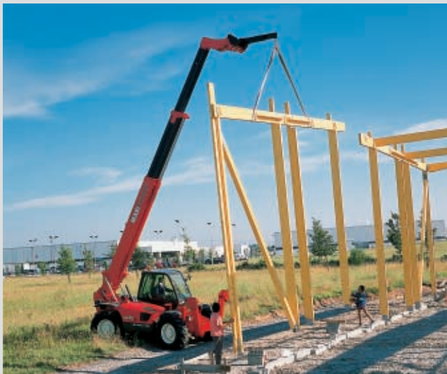
...handhaben von sparrigen Lasten mit dem Kran-ausleger mit Haken P 4000 MT...
